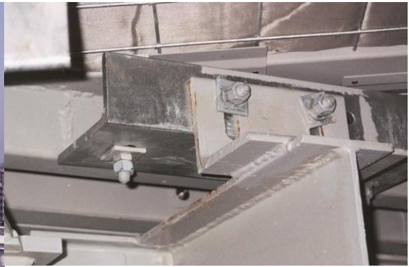
ドーム鋼材締結
